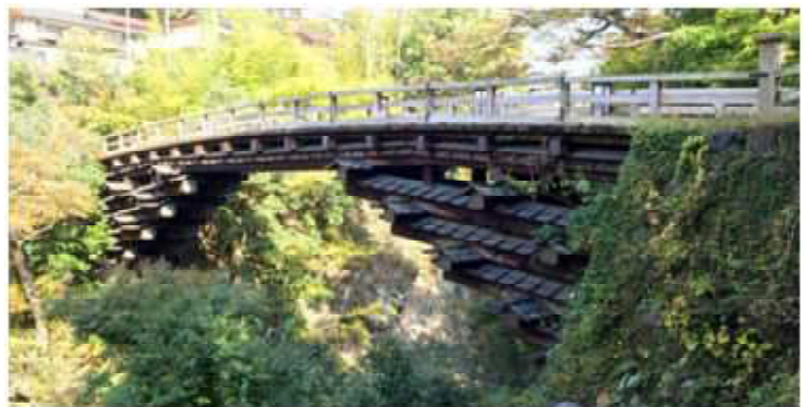
写真3 山梨県大月市に架かる「猿橋」
