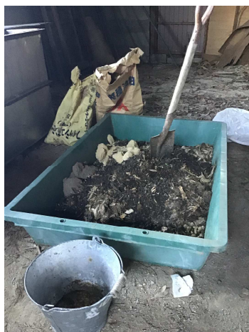
材料を混ぜあわせている様子
