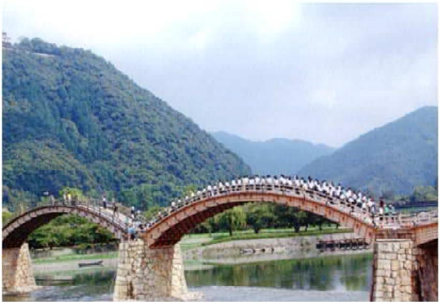
写真2 地元の高校生による載荷試験
