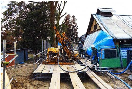
基礎工事(地盤地滑り対策工事)
