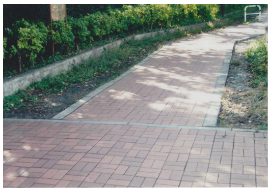
写真5 インターロッキングの舗装
