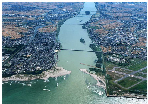
阿賀野川河口(国土交通省阿賀野川河川事務所提供)
