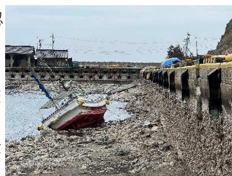
写真3 地震後の鹿磯漁港
