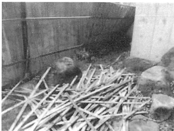
写真2 竹垣の解体（もう一度使用するためにきれいに解体）
