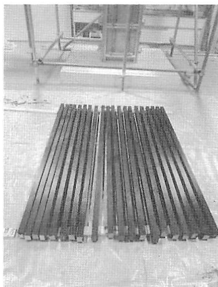
写真6 黒ペンキによる枠組の塗装
