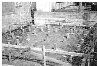
写真1 2期・3期棟の基礎に用いた木杭
