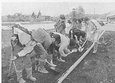
写真2 パイプの設置
