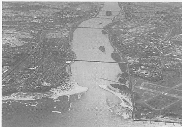
写真 阿賀野川（国土交通省阿賀野川河川事務所提供）
