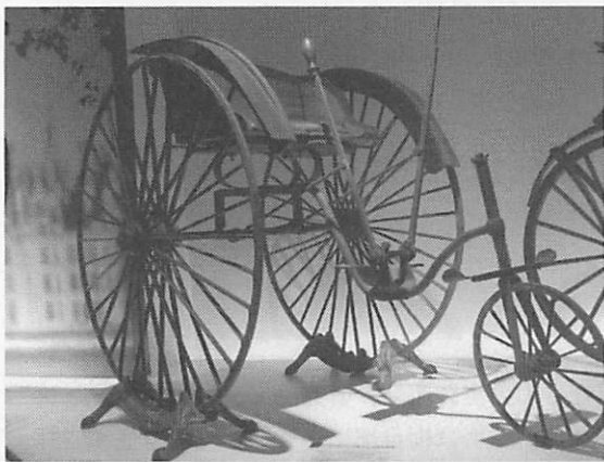
写真1 愛媛県八幡浜市で見つかった三輪自転車(トライシクル)チエンが発明前でクランクアームで駆動(1870年ごろの生産か)
