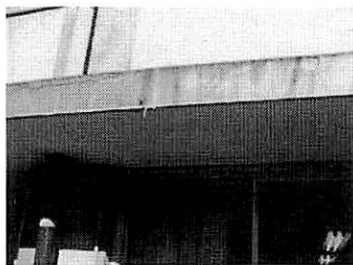
写真6 溶け出しているコンクリートつらら
