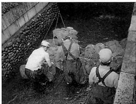
写真1 釜川での炭設置風景
