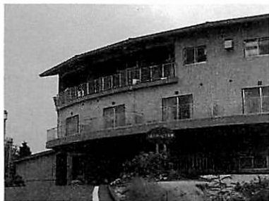
写真1「風のがっこう京都」の建物外観
