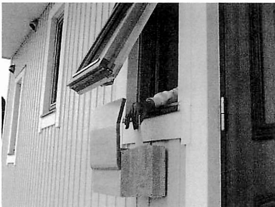
写真3 窓から手紙類を回収（蝶番の位置が変更され、ふたが後ろ開きになった）
