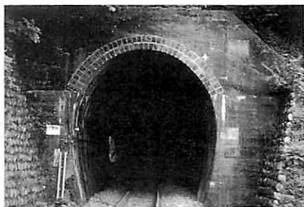
写真4 不動野トンネル
