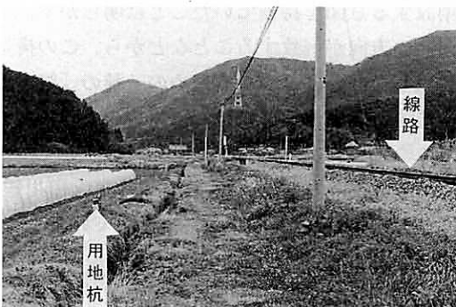
写真5 複線分の用地線路と用地杭の位置に注意)
