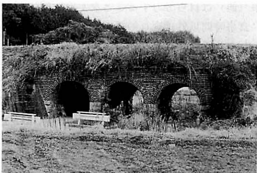
写真2 内田川橋梁の「げた歯」側
