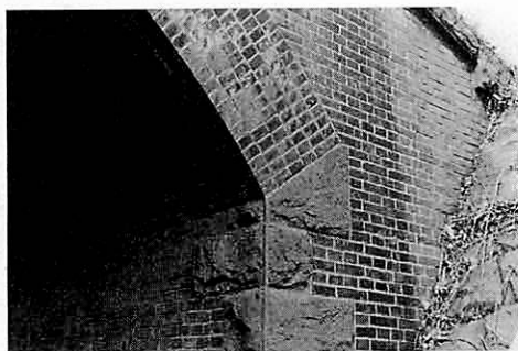
写真5 アーチを支える迫受石 (信州往還架道橋)
