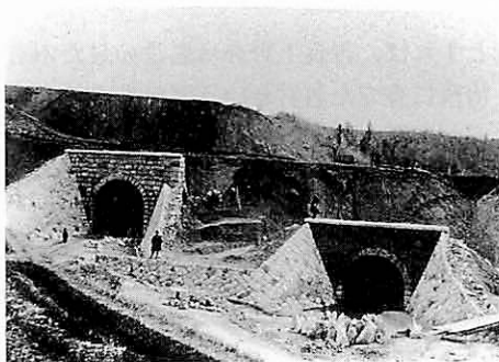
写真1 盛土で被われる工事中のアーチ橋
