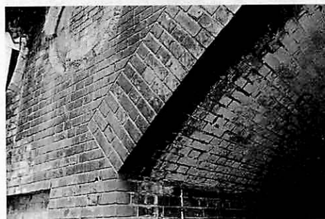
写真6 迫受石のないアーチ橋 (第四有楽町橋高架橋)
