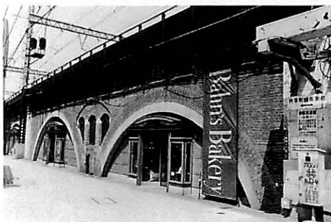
写真2 アーチ高架橋の例(内幸町橋高架橋)
