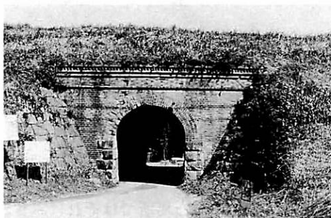
写真3 盛土の下のアーチ橋(第165号橋梁)
