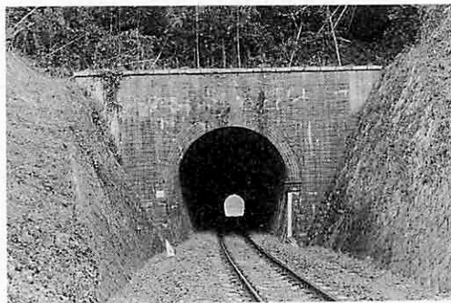
写真2 坂本トンネル坑門
