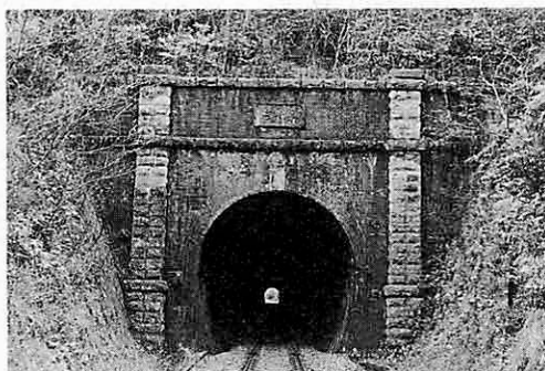
写真1 新谷トンネル坑門
