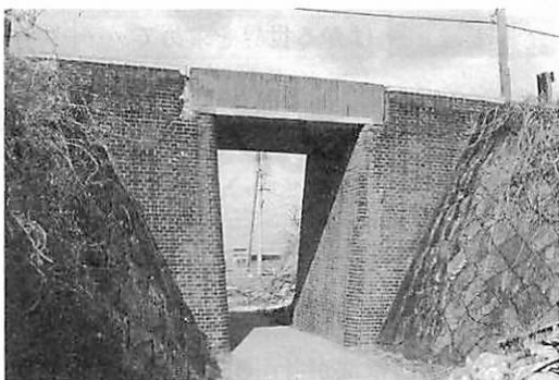
写真6 第三大崎橋梁
