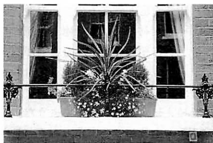
写真3 窓枠との調和も考えてデザインされたウインドウボックス
