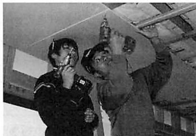
写真3 建築現場での職場体験の様子
