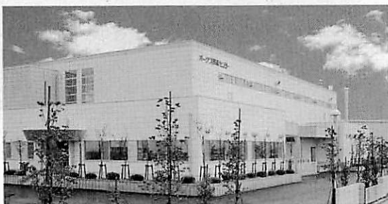
写真3 断熱サイディングを採用した建物
