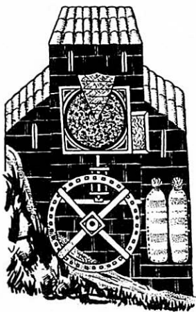
図1 中世の絵にみられる製粉用下掛け水車(13世紀後期)。出典：T.S.レイノルズ『水車の歴史』
