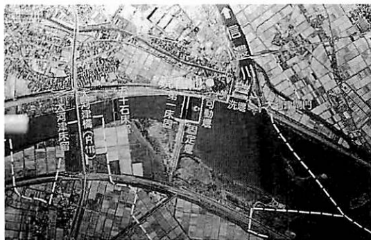
写真2 大河津分水の航空写真
