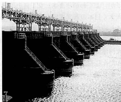
写真3 制御する巨大な堰（左）信濃川の流れを一定に保つ洗堰、 （右）大河津分水の流れを制御する可能堰（手前）と固定堰（奥）
