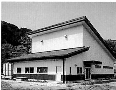
写真1 越生町の高度浄水施設
