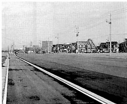
写真1 広大な道路の宅地造成
