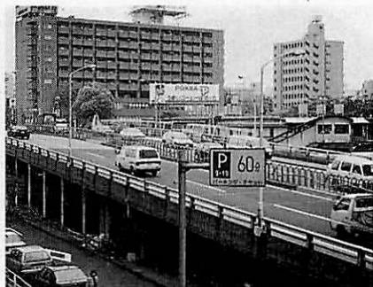
写真4 高架式道路により 地域が切断される
