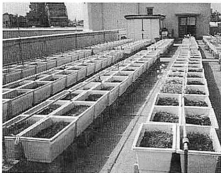
屋上に設置したプランターと給水装置
