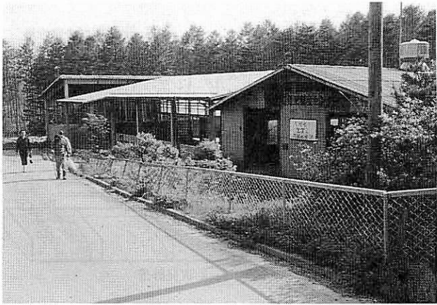
白田町堆肥製産センター
