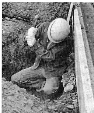
写真12 接地工事
