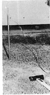
写真7 アース棒を30cm埋め込んだところ
