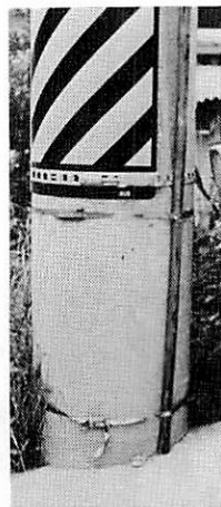
写真3 既設の電柱に設けた接地線
