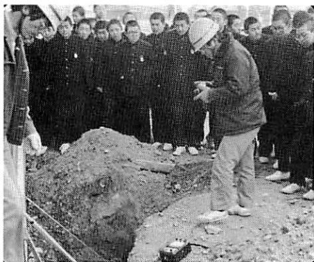
写真13 接地工事の見学
