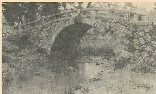
潮観橋(親柱方角、勾欄方杖支え)
